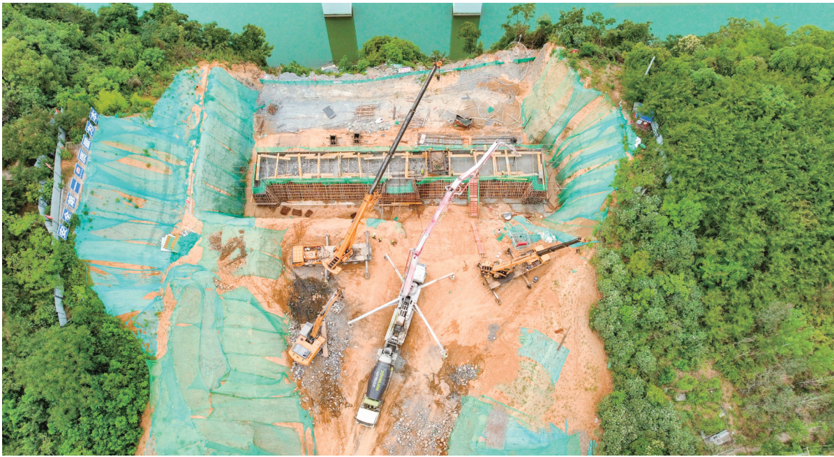
南岸桥台混凝土浇筑
