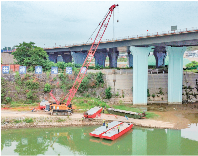
补焊防渗处理
