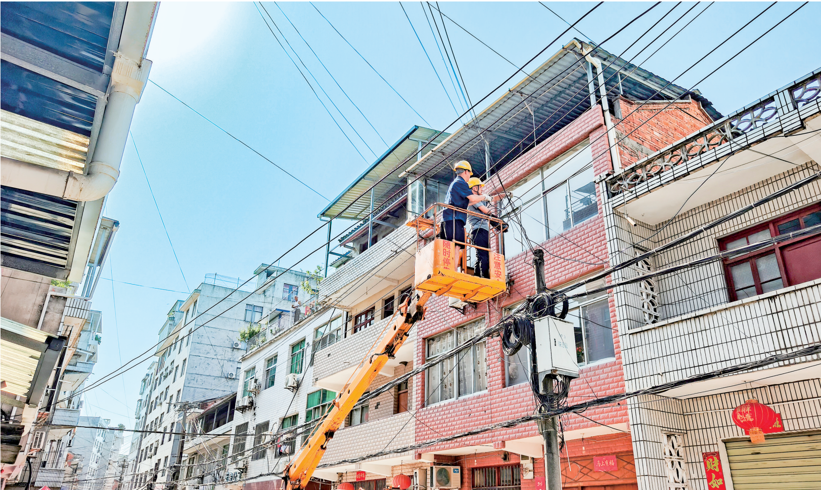
7月9日,施工人员在汉滨区新城街道心石村进行路灯架空线路改造。此次改造通过单独架设路灯专用零线,消除老旧线路共用零线造成的供电故障隐患,进一步筑牢街巷电网安全基础。 钱运立 刘宇翔 摄
