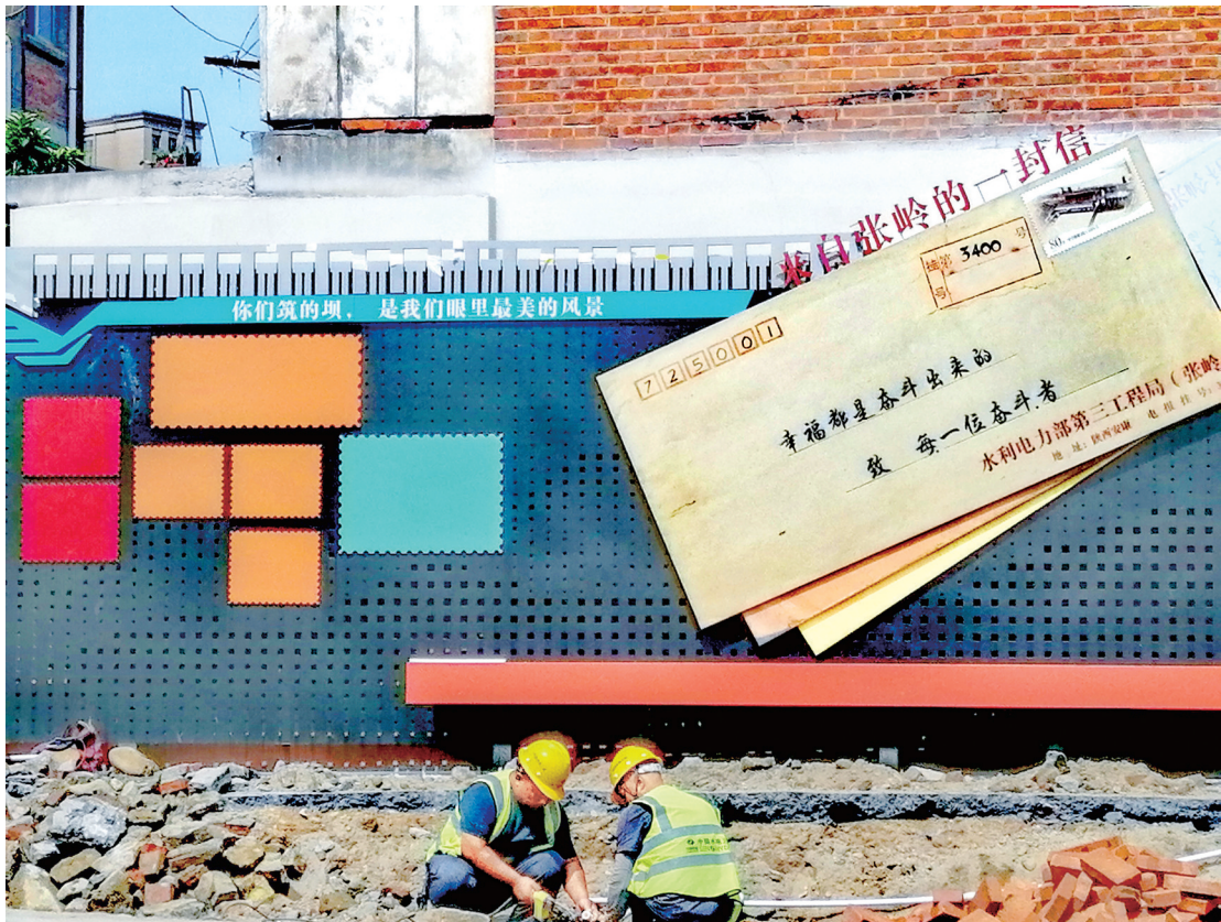
7月6日，安康中心城区水电三局张岭片区老旧小区改造（三期）配套基础设施项目稳步推进。项目主要建设内容包括道路、排水、公共活动区、便民设施等，预计今年年底竣工。
