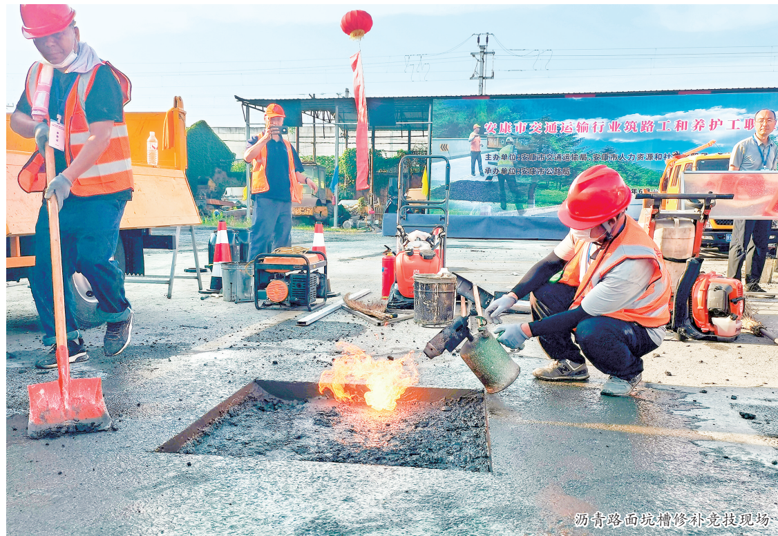
沥青路面坑槽修补竞技现场
