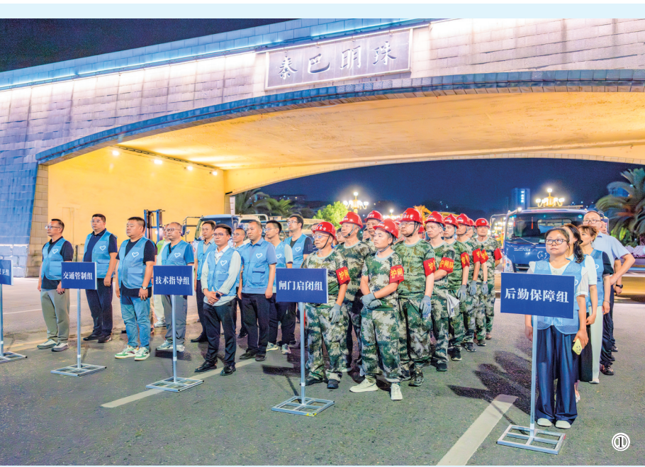
①演练前动员 ②安装防洪闸门 ③防洪闸门安装完成
