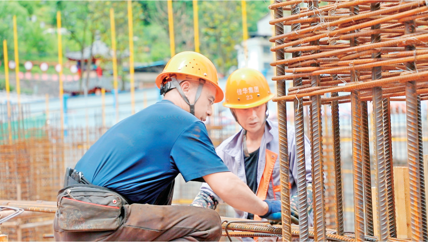
6月10日，镇坪县城东综合停车场建设项目正抢抓工期加紧推进。该项目采用地下集约开发模式，不占用地面公共空间，地面同步规划休闲绿化区域，兼顾停车需求与城市景观提升。项目建成投用后，可有效满足周边就医群众、居民、商户停车需求，提升县城宜居度。 屈光波 摄
