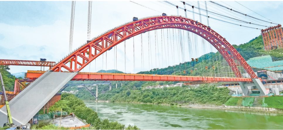
6月12日，由中铁十九局承建的西渝高铁安康汉江大桥顺利合龙。该大桥是西渝高铁控制性工程，建成后对西渝高铁早日通车具有重要意义。 陈德模 摄
