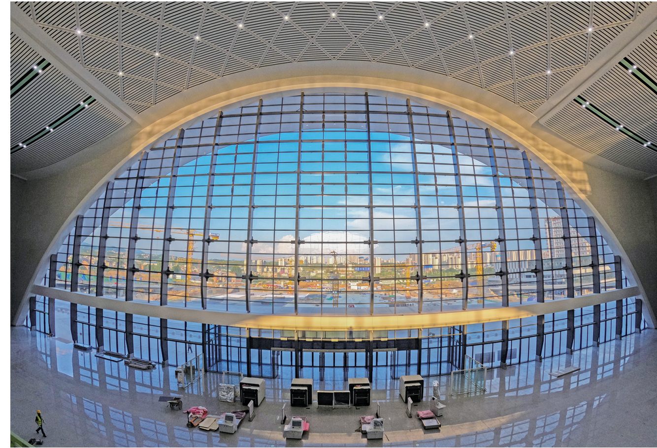
西渝高铁安康西站抢抓工期稳步推进工程进度。目前，站前广场和地下停车场已进入收尾阶段，为顺利通车筑牢基础。图为6月29日拍摄的候车大厅。林江 摄
