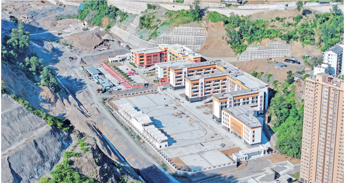
6月22日,紫阳县第三小学项目建设稳步推进。目前,教学楼、水电网等主体建筑及配套设施均已竣工,正加紧实施室外道路铺设、操场软化等收尾工程,预计今年9月正式交付使用。该校建成投用后,将有效补齐县城办学硬件短板,优化本地教育资源布局。毛润 摄
