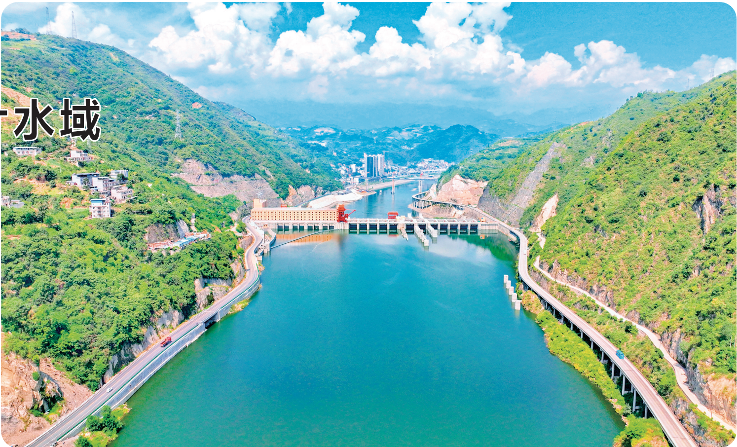
航拍下的旬阳水电站,拦河大坝横卧汉江之上,碧水澄澈,青山苍翠,尽显水利工程与自然和谐相融的面貌。
