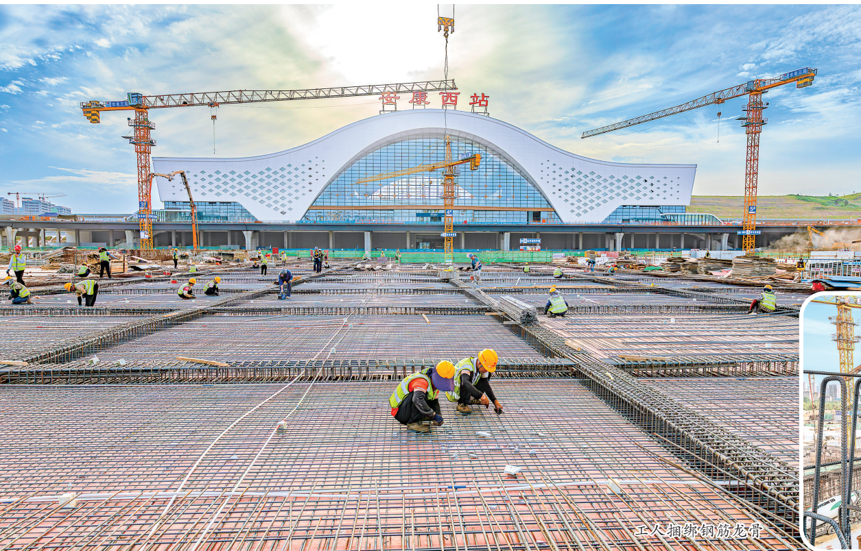
6月4日，烈日炎炎，西康高铁安康西站施工现场热火朝天。目前，站房主体工程已经完工，附属工程正全面推进。
