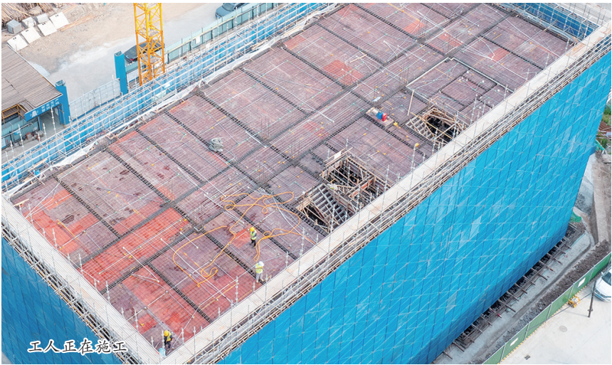
项目施工现场
