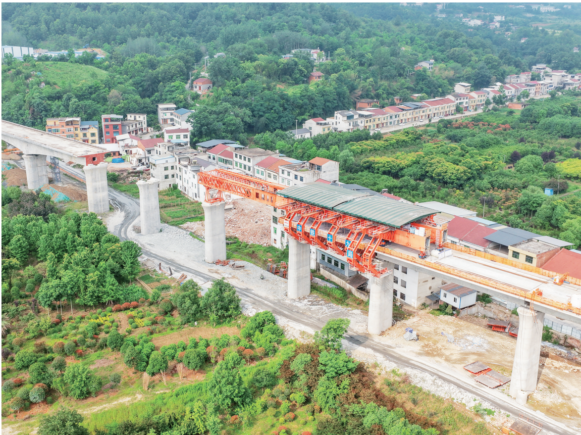
位于安康高新区任家坝村的安康特大桥是西渝高铁康渝段控制性重点工程,全长3053.59米。大桥落成后,将打通陕川渝快捷客运大动脉,赋能秦巴山区发展。图为6月3日,工程建设正加速推进中。皮勇维 摄
