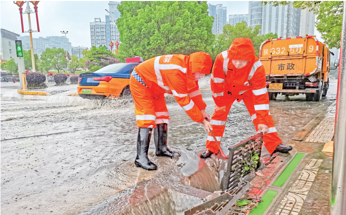
5月28日,安康城区突降暴雨,部分路段出现短时积水。安康市市政园林处作业,清理排水口杂物,掀起雨水篦子,加速排水,保障道路通行安全。 钱运立 摄
