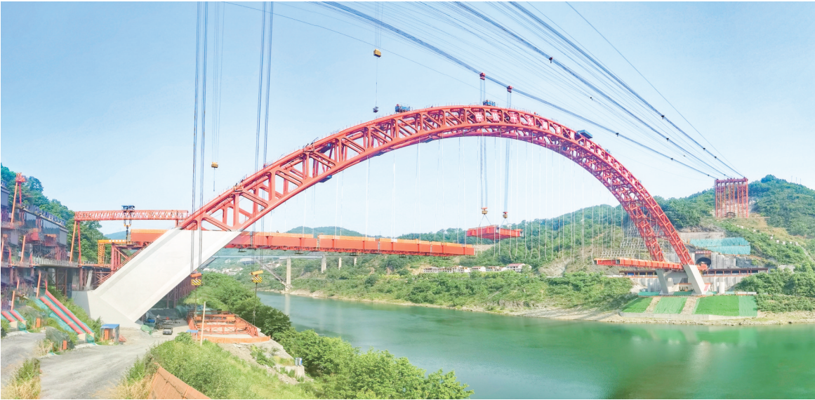
近日，由中铁十九局承建的西渝高铁控制性工程——安康汉江大桥建设有序推进。图为缆索吊机正在进行钢混结合梁架设作业。
