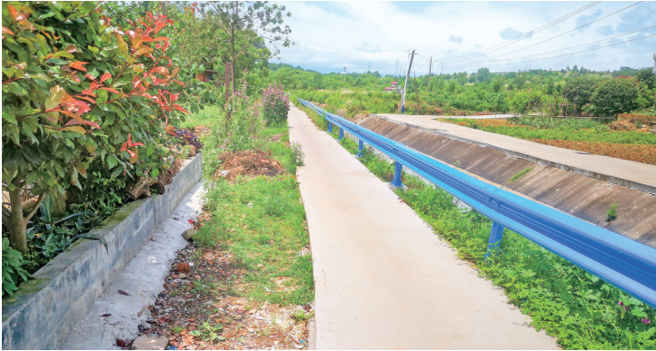
新硬化的水泥路
