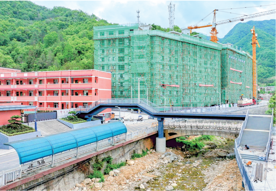
5月14日,宁陕小学人行天桥项目施工现场,施工人员抢抓工期,全力推进项目建设。目前,宁陕小学人行天桥主体结构施工已过半,建成后将实现人车分流,有效缓解学校附近交通拥堵,保障师生及行人安全。
