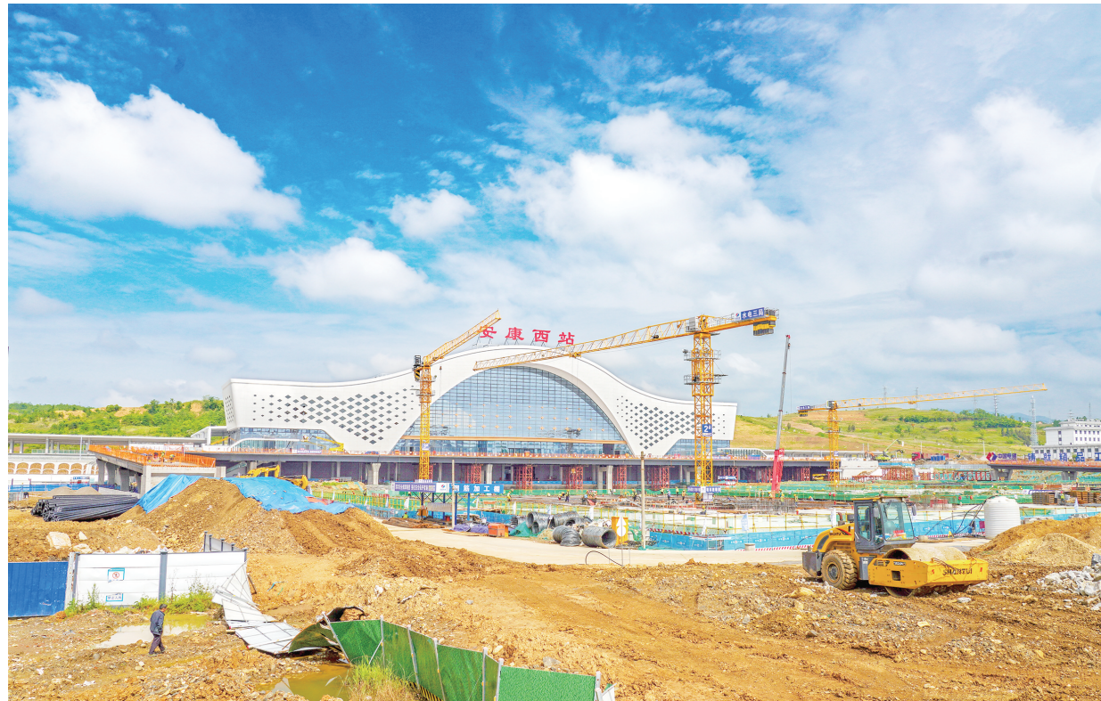
5月7日，西康高铁安康西站施工现场塔吊林立、机械轰鸣，建设者们有序推进配套工程收尾与场地平整作业。目前，站房主体工程已基本完成，周边配套建设进入冲刺阶段。
