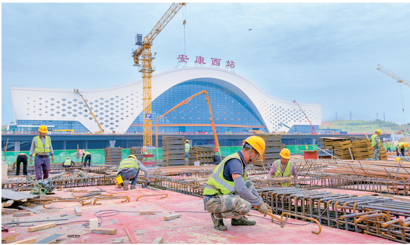
5月1日,西康高铁安康西站站前广场建设现场,一派热火朝天的奋战景象,建设者们放弃休假坚守岗位,全力冲刺项目建设收官目标。
