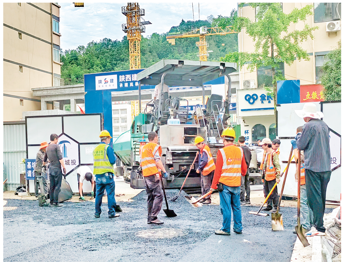
4月27日,岚皋县老城北区排水设施建设项目(二期)肖家坝片区进入沥青面层施工阶段。目前,项目涉及的仰韶路西段、溢河路、永安路已进入沥青面层施工阶段,下一步将加快花里路、官元路、滔河路、佐龙路等道路施工。吴小琴 摄
