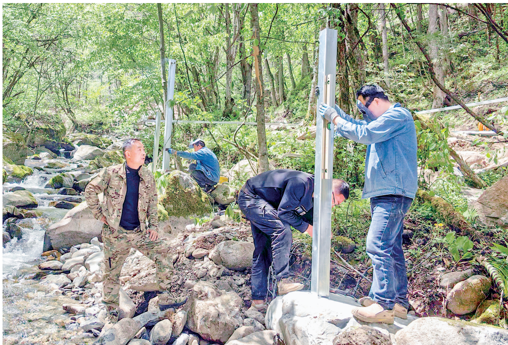
叶胜峰(左一)和工人正忙着建设溪边咖啡平台。
