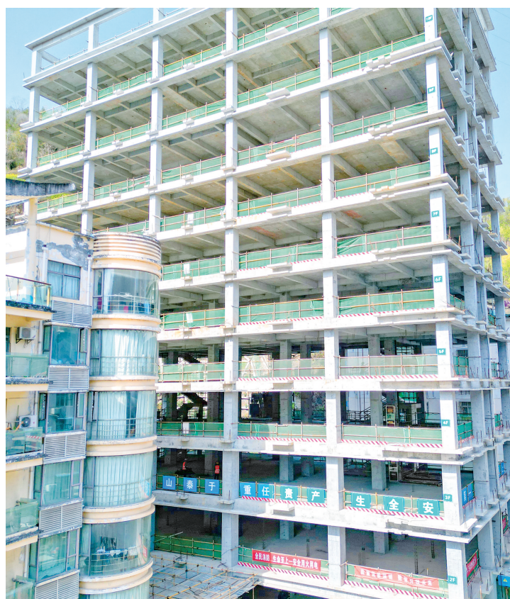
白河县第二人民医院综合楼建设项目综合楼主体部分已建设完成。 卫浩 摄
