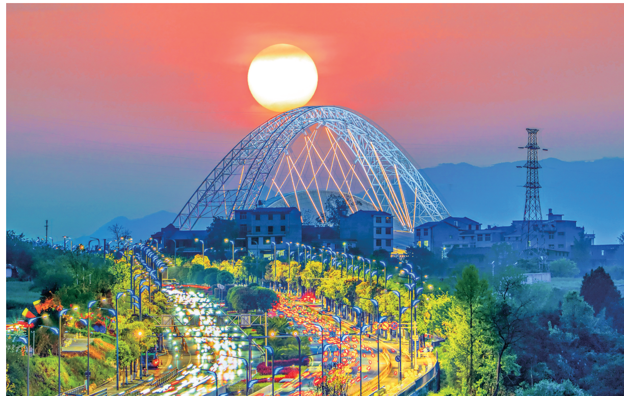
4月9日日落时分，安康市体育馆外车流如织，一轮夕阳沉落于体育馆穹顶之上，春日晚霞风光令人沉醉。
