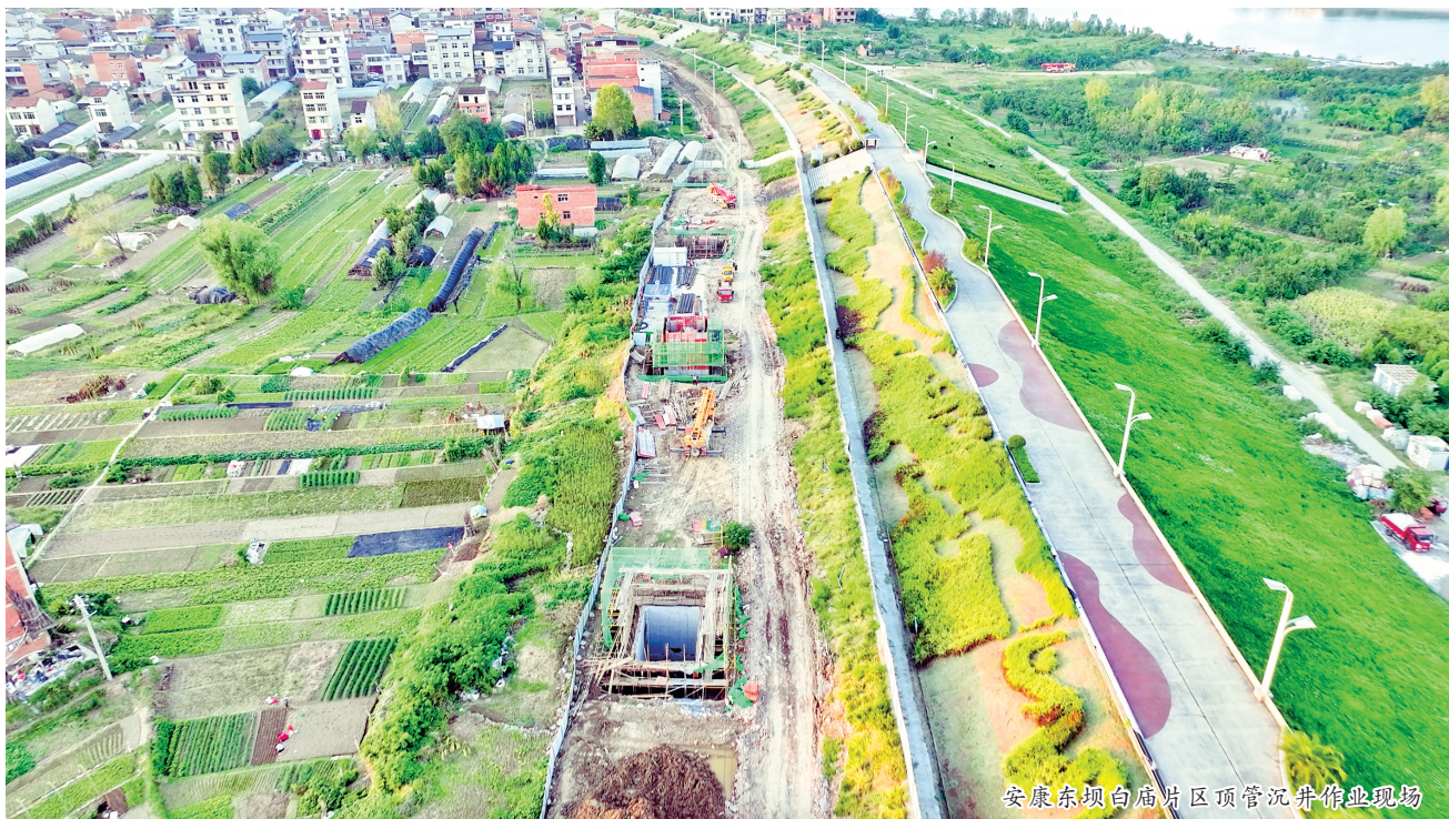
安康东坝白庙片区顶管沉井作业现场
