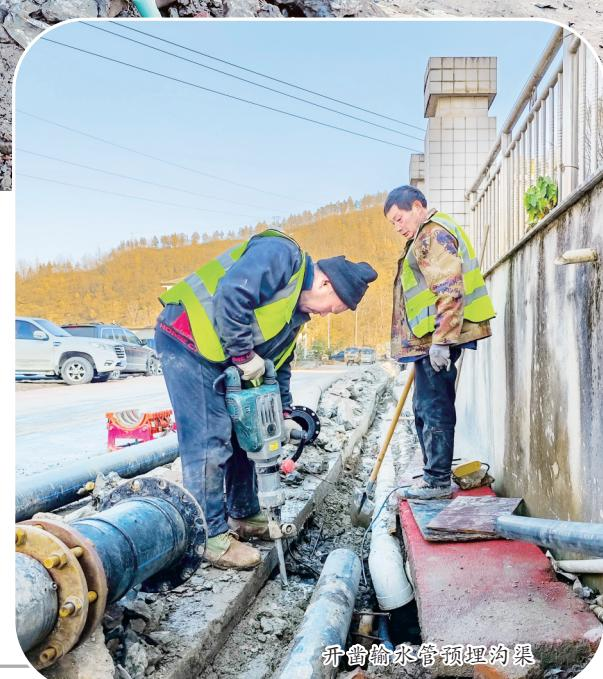
近年来，旬阳市稳步推进城乡供水基础设施建设，通过更换老旧管网、升级改造配套设施等举措，着力补齐供水不足、水压不稳定等饮水保障短板。图为1月11日，在旬阳市蜀河镇施工工地，工人正在施工。该工程将新建一座200立方米的蓄水池，更换老旧管道3313米，工程完工后将惠及沿线1万余名群众。
