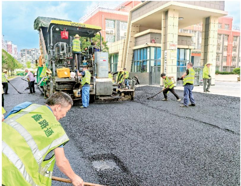
8月7日,安康中心城区金城路西关小学段,施工人员正在开展道路上面层铺设作业。作为西坝片区重要路网项目,金城路南起金城路小区,北至永安路,全长165米,宽12米,目前工程进度已达80%,计划8月中旬全面完成金城路及永安路、教生路的沥青面层铺设。 钱运立 张旭 摄
