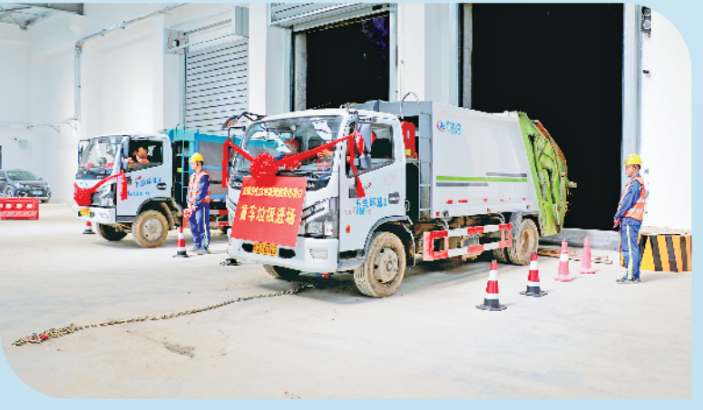
安康市生活垃圾焚烧发电项目首车垃圾进场
