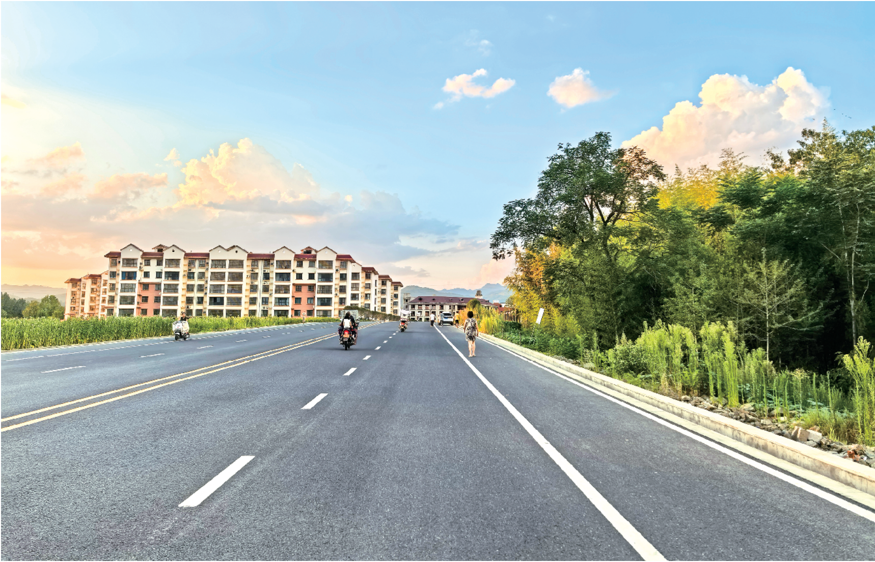
7 月 30 日,恒口示范区恒惠大道风景如画。该大道全长 1.2 千米、宽 19 米,位于示范区的东红、江沟、杨庄等村(社区)交汇处,起接 316 国道,终至江沟社区,后期将延伸至机场大道。 张天兵 摄
