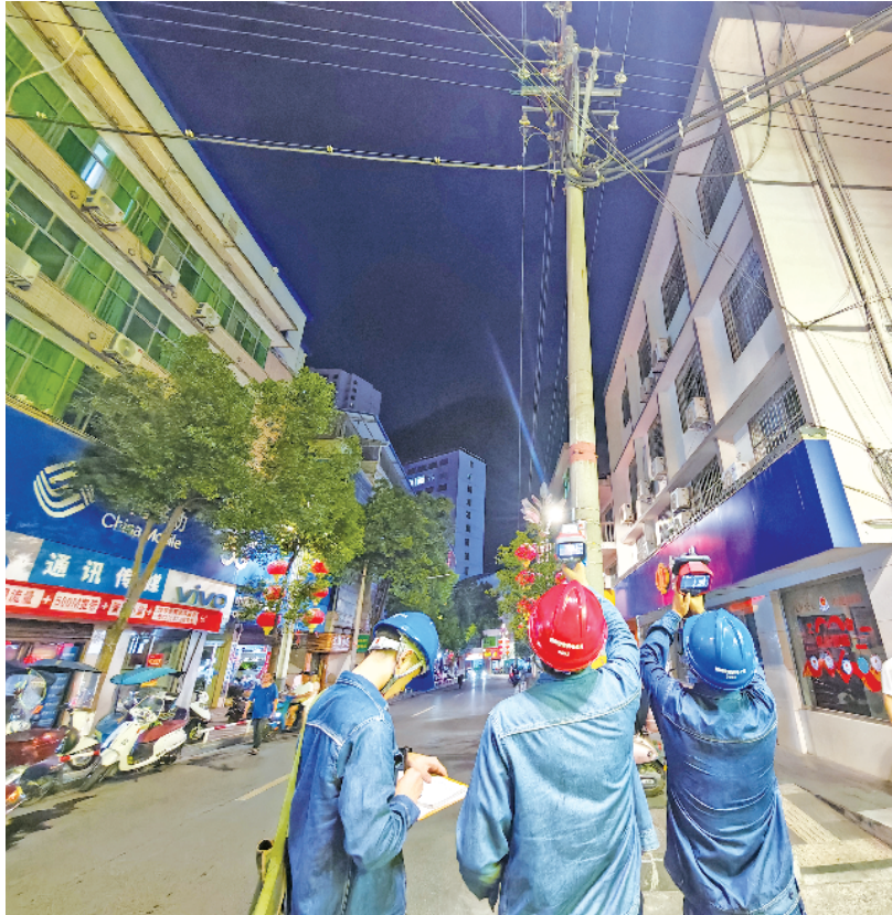
为保障居民清凉度夏，近期，国网坪坝供电公司组织开展线路巡视工作。 杨啟明 摄
