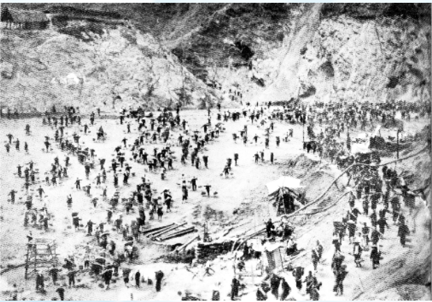
原“八一”水库修建现场
