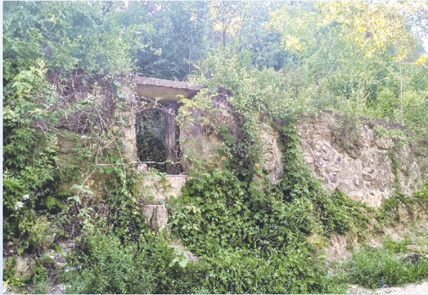
老二挡渠的溢洪口
