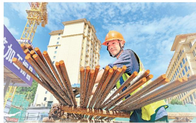
连日来，在宁陕县三星康养综合体建设项目二期（祥洲小区）施工现场，工人们有序进行钢筋绑扎、混凝土浇筑作业。目前，1号楼正在进行地下负一层施工，2号楼实施主体结构建设。王辉 摄
