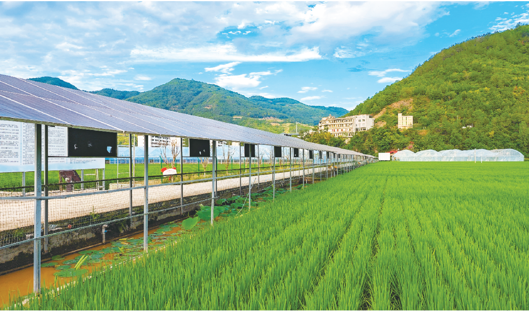
近年来,旬阳市积极探索创新,采用“农田+水产+光伏”模式,实现农业生产、水产养殖与光伏发电协同发展。该模式不仅推动了当地绿色低碳发展,还促进了新能源与乡村振兴的深度融合。图为7月2日旬阳市双河镇高坪社区的“田里种稻+渠中养鱼虾+渠上光伏”新型农田种植模式。
