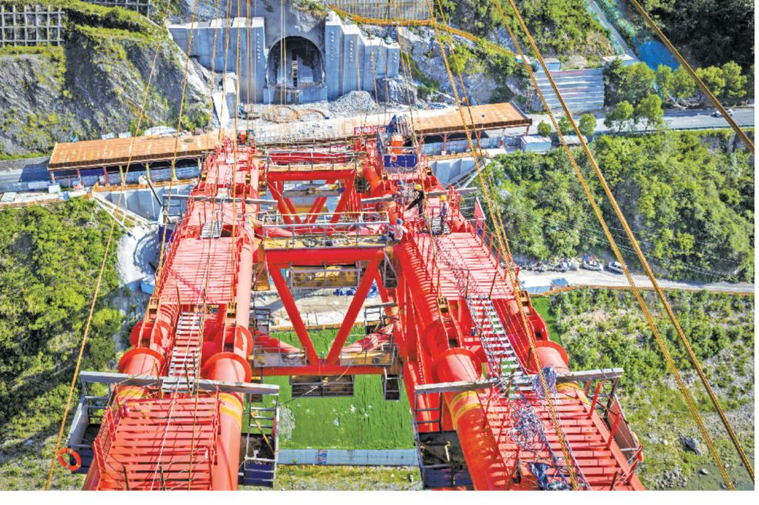
7月4日，西渝高铁安康汉江大桥钢拱安装建设现场，工人们干劲正酣。该大桥全长367.9米，采用钢混组合梁结构，主梁设计采用了半漂浮约束体系。该桥跨越了G211国道、汉江和S207省道。主跨采用缆索吊装法，边跨采用支架吊拼法施工。 刘宗才 摄
