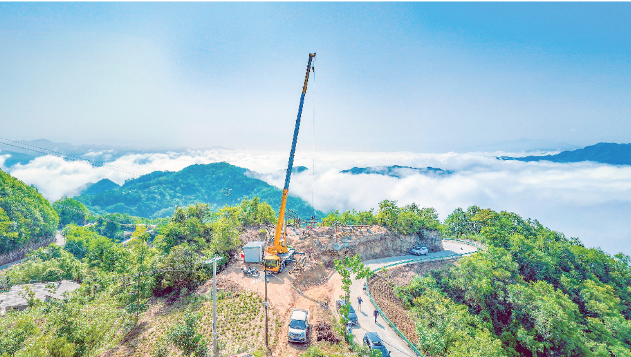
6 月 15 日,石泉县枫林云海乡村旅游配套设施建设项目有序推进,核心建筑之一云海观景台正加紧施工,预计年底正式投入运营。该项目总投资 8000 万元,建成后 will 把汉江烟波湖度假区、汉江宿集、枫岭云海、秦巴风情园串联成旅游环线,进一步丰富石泉旅游资源,辐射带动周边群众增收。
