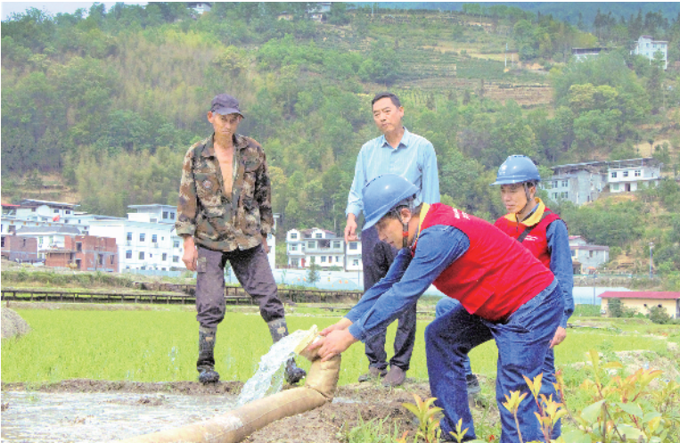
紫阳县农业及电力部门通过调运大型抽水泵、架设供电线路、铺设供水管道等办法，为高桥镇水稻种植基地送去“及时雨”。
