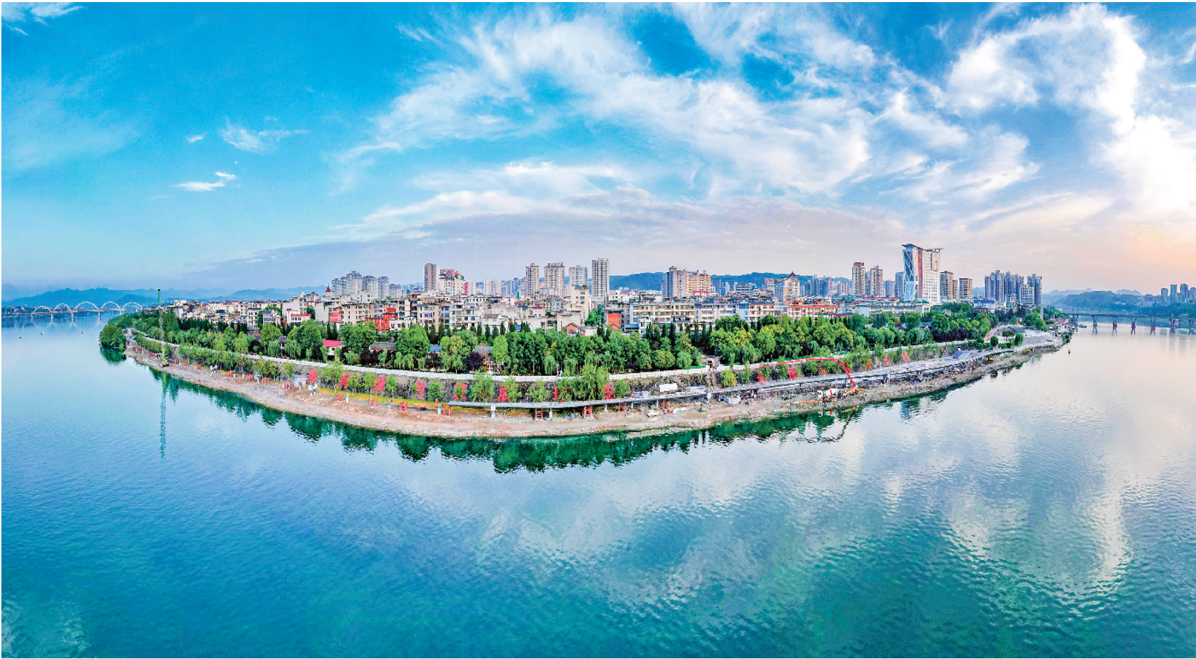
5 月 22 日,雨后初晴,安康中心城区滨江慢行系统修复工程稳步推进中。
