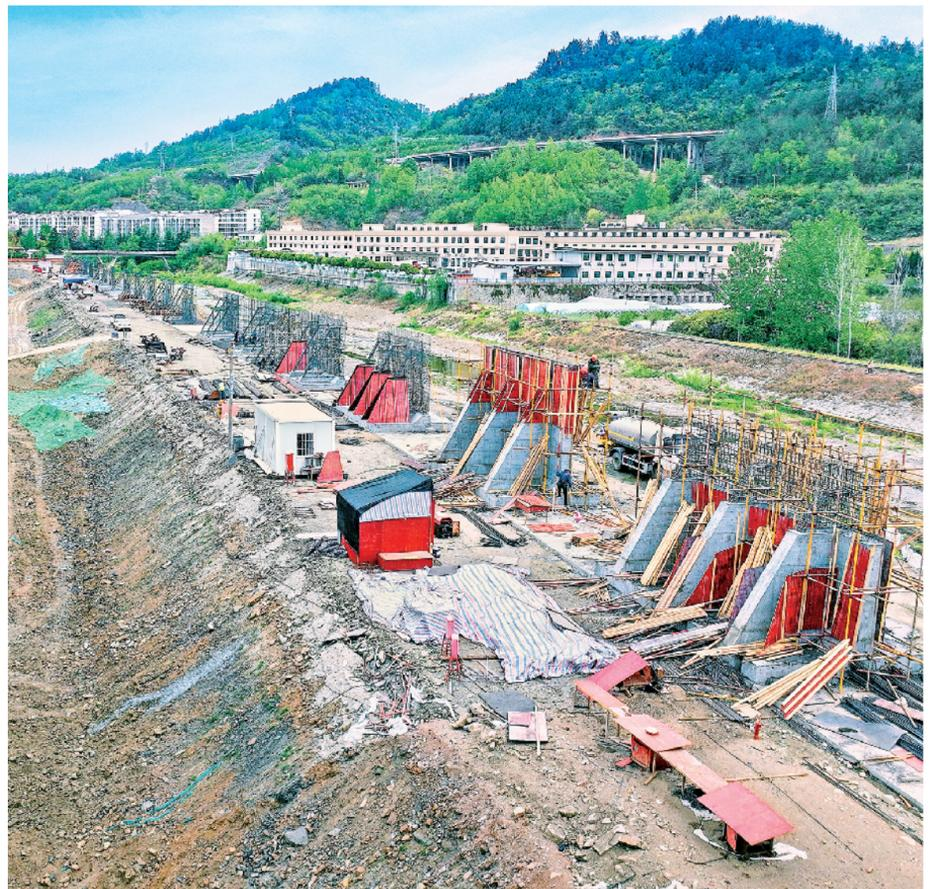
4月15日,在石泉县城关镇杨柳防护区(右岸)综合治理项目建设现场,施工人员在抢抓黄金施工期进行防护河堤浇筑作业,在安全生产前提下推动项目提速完工。据悉,该项目总投资1.386亿元,包含堤防、下河踏步等防护工程,建成后将有效改善县城严峻防洪形势,推动县域经济高质量发展。
