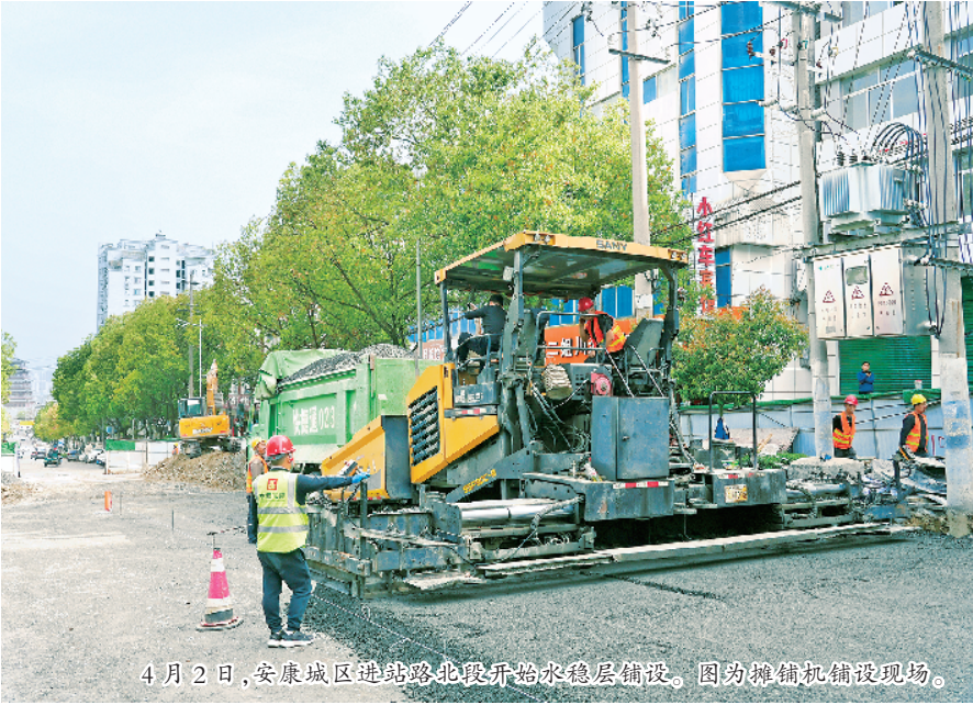
4月2日，安康城区进站路北段开始水稳层铺设。图为摊铺机铺设现场。
