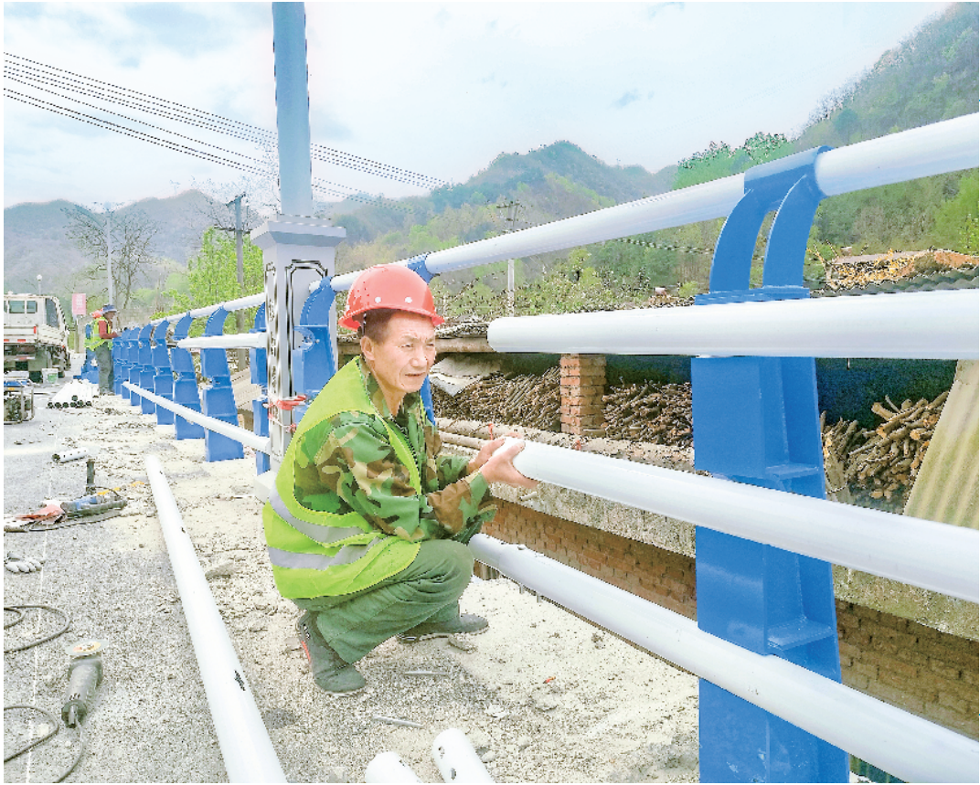
近日,在宁陕县城关镇关池路段,施工人员正在对改造升级的路段进行安全防护处理,通过安装防护栏提升道路安全防护水平,确保行人通行安全。据悉,此次重点对关池路段1243米道路,安装具有耐腐蚀、抗冲击、高安全系数等特点的不锈钢护栏。 王辉 摄
