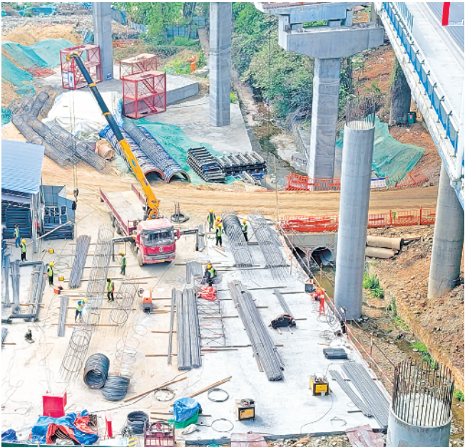
4 月 9 日，七里沟立交桥项目建设现场一角，施工者正在绑扎钢筋。
