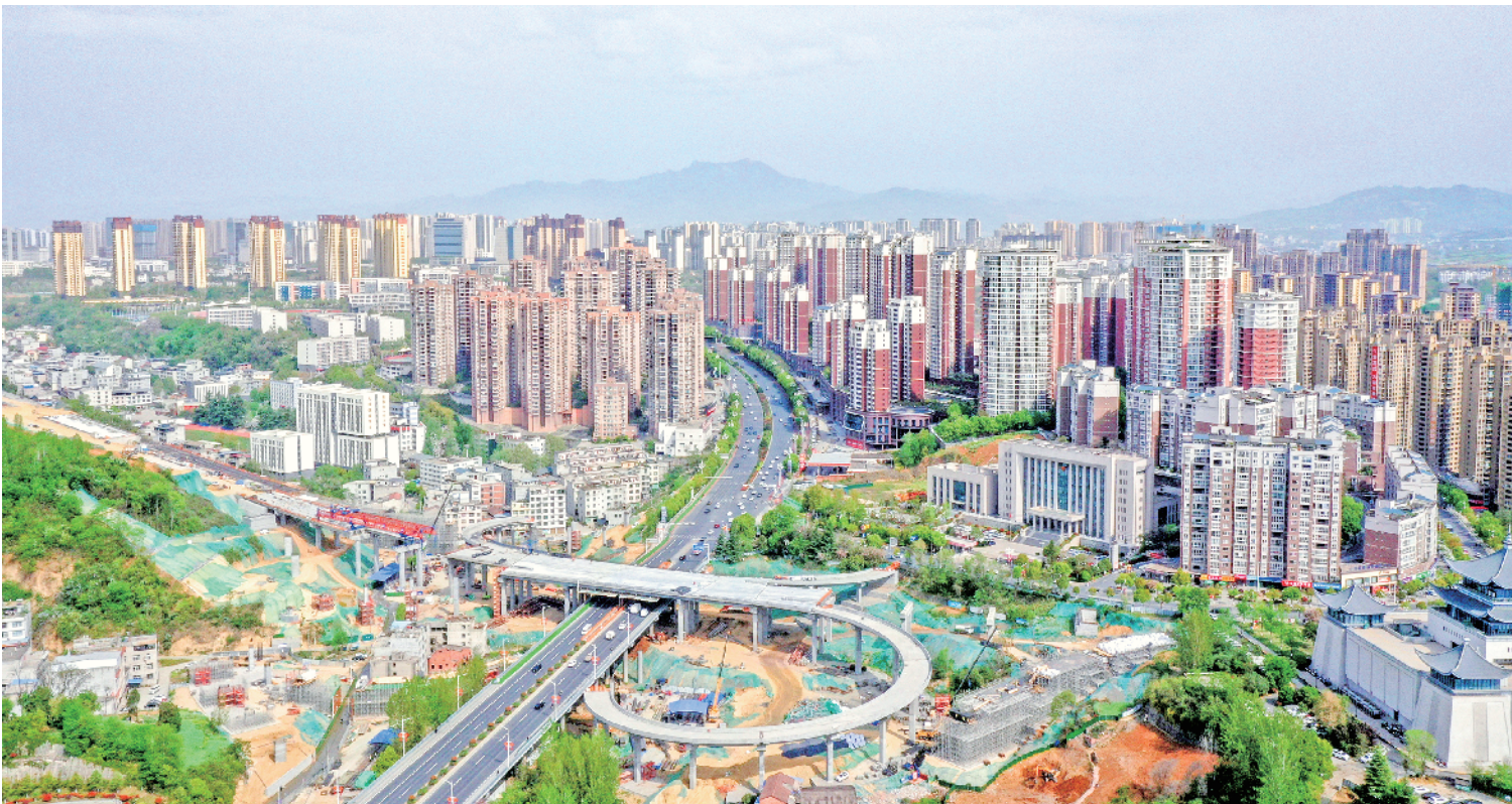
4 月 9 日，航拍镜头下的七里沟立交桥项目。
