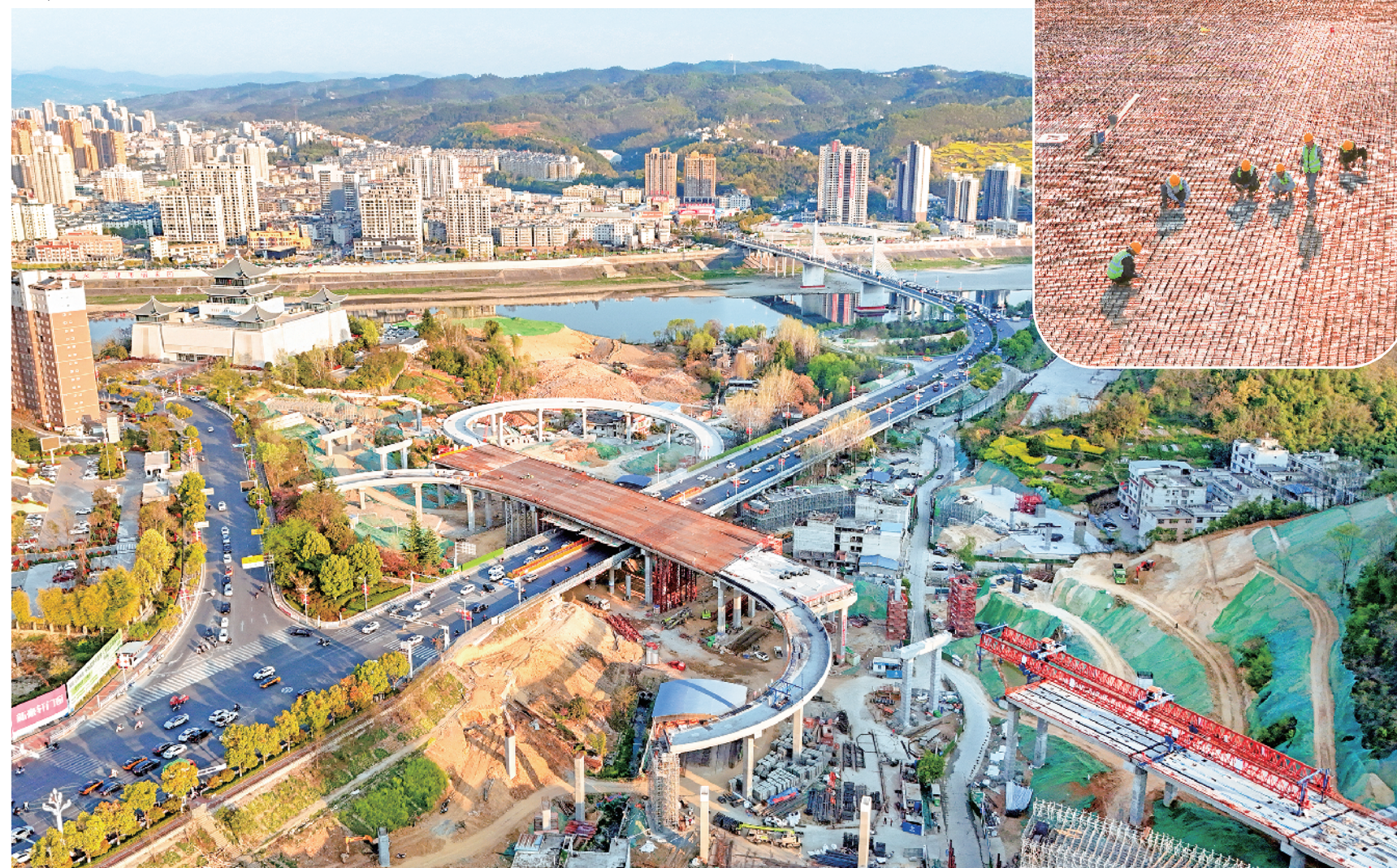
3月26日,安康城区七里沟立交桥施工现场,机械轰鸣,工人正在进行桥面铺装、路基填筑等工作。据了解,该项目是我市重要民生工程、重点工程,同时也是安康城区第一座全互通苜蓿叶式市政立交大桥,预计2026年6月建成投用。 赵华斌 摄
