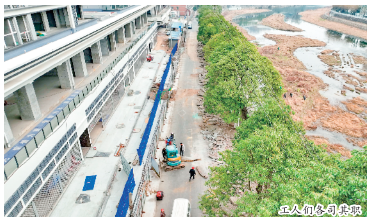
3月12日,工人们在汉阴县经济技术开发区天然气管道更新改造项目(二期)施工现场,进行管道铺设和焊接作业。该项目是汉阴县2025年重点建设项目之一,改造内容包括燃气工程及道路、雨水、通信等相关附属设施拆除、恢复。徐欢 文婷 摄
