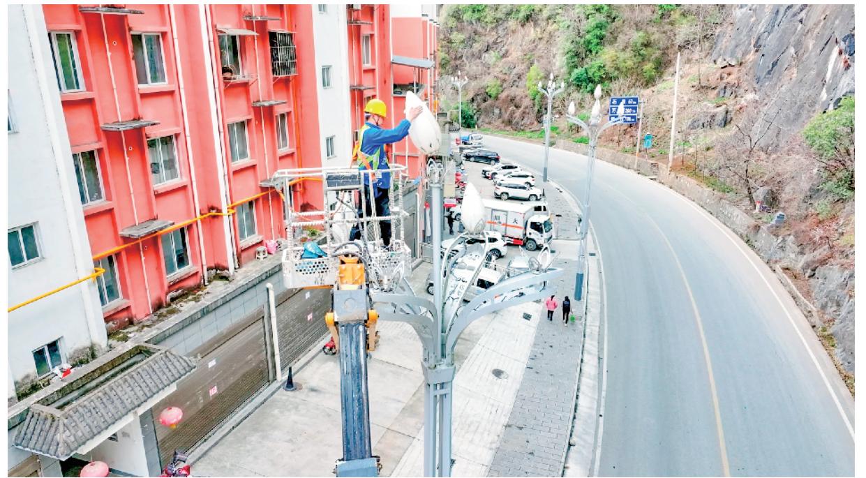
连日来,宁陕县实施城区照明工程,组织对城区主干道、背街小巷照明路灯进行排查,更换LED节能灯,累计安装新型路灯175套,更新沿河照明设施4.5公里,完成12座桥梁照明设施及沿街41栋建筑天际线安装,智能化改造率达100%。图为3月18日,工作人员在子午路段进行路灯维修更换。王辉 摄
