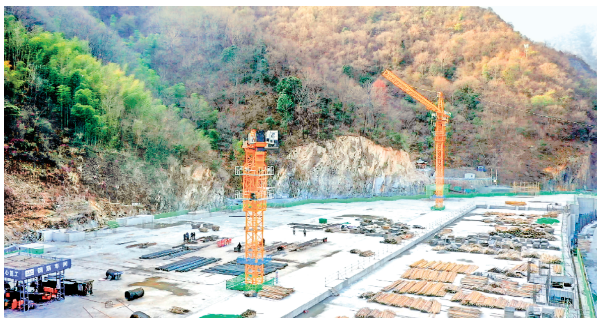
镇坪县黄龙潭运动公园建设项目规划占地面积35800平方米,计划总投资为4.7亿元,是该县完善城市健身运动休闲功能,改善人民生活品质的重要公共服务和基础设施。 屈光波 摄
