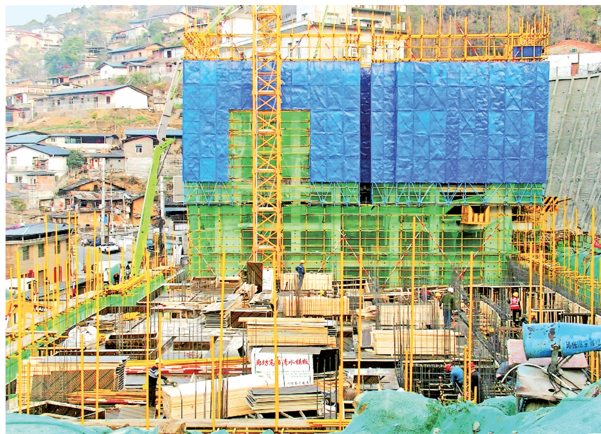
紫阳县城东城门社区、仁和国际印象水岸美食街区和滨江商业街片区等城市重点项目建设正全面推进,县法院片区棚户区改造项目也在如火如荼建设中。图为3月2日法院片区棚户区改造项目施工现场。 彭召伍 摄
