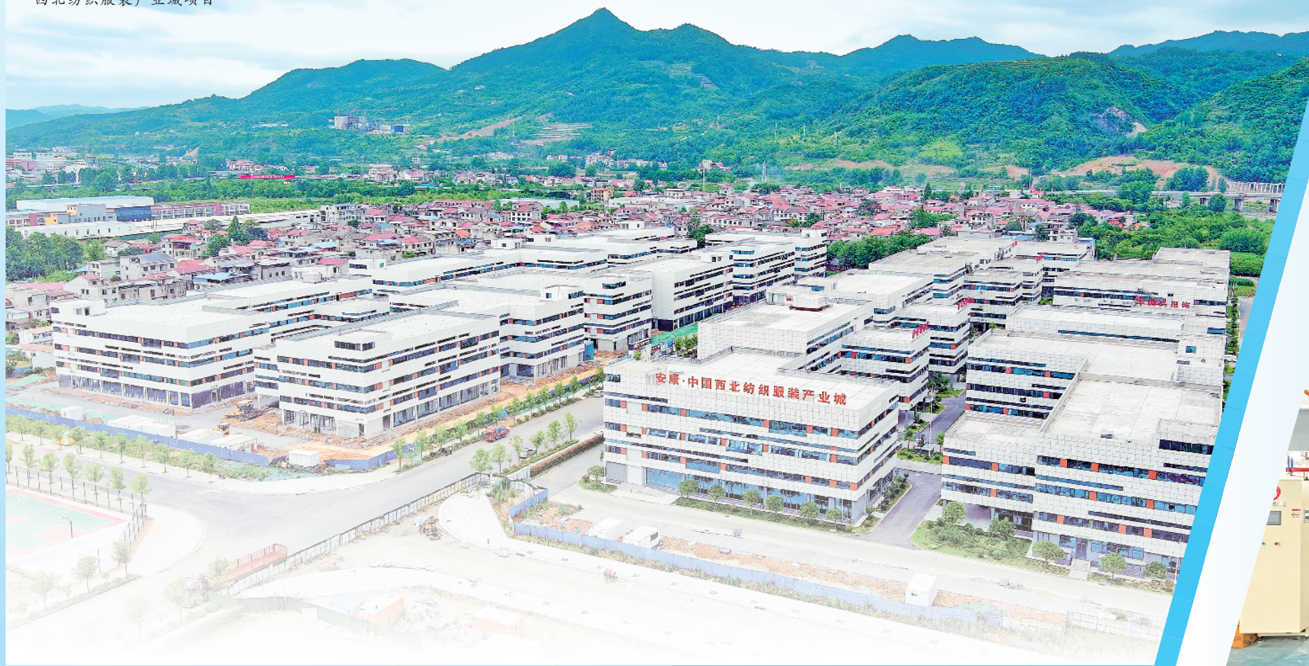
西北纺织服装产业城项目
