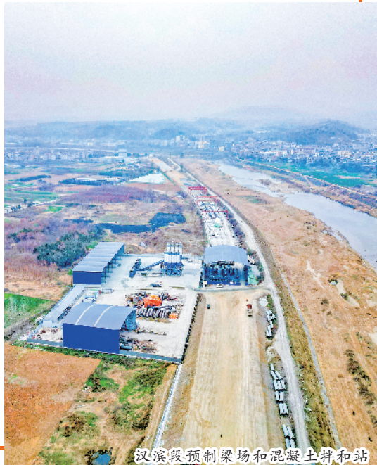
汉滨段预制梁场和混凝土拌和站
