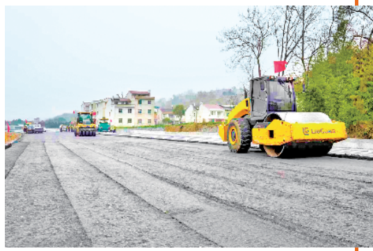
沥青路面铺设
