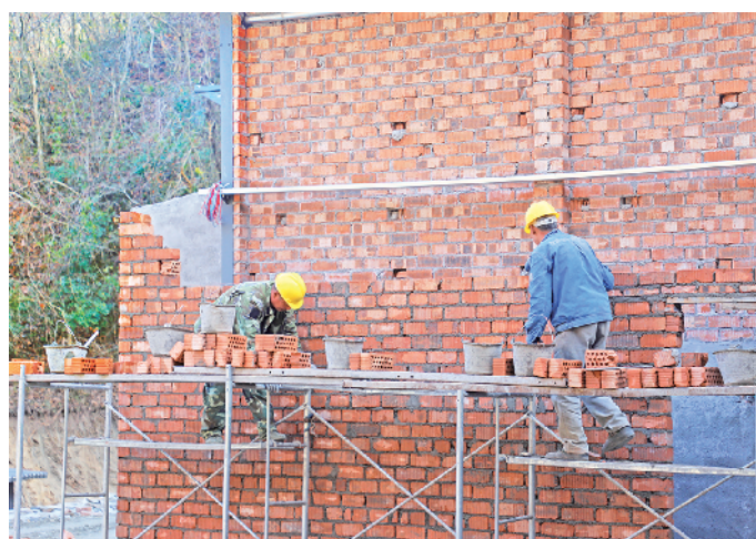
施工现场工人们加紧砌墙
