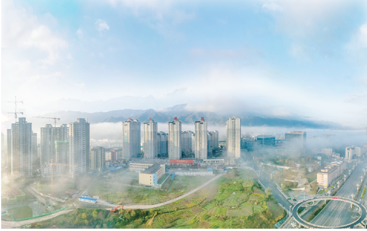
汉阴县近年来优化提升城市功能品质，大力实施城市更新，积极推进保障性住房、城中村改造等工程，完善市政基础设施，着力提升城区防汛排涝能力，建设海绵城市、韧性城市，打造高效、便捷、宜居的智慧城市。
