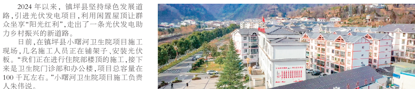
完成安装的建筑屋顶。
