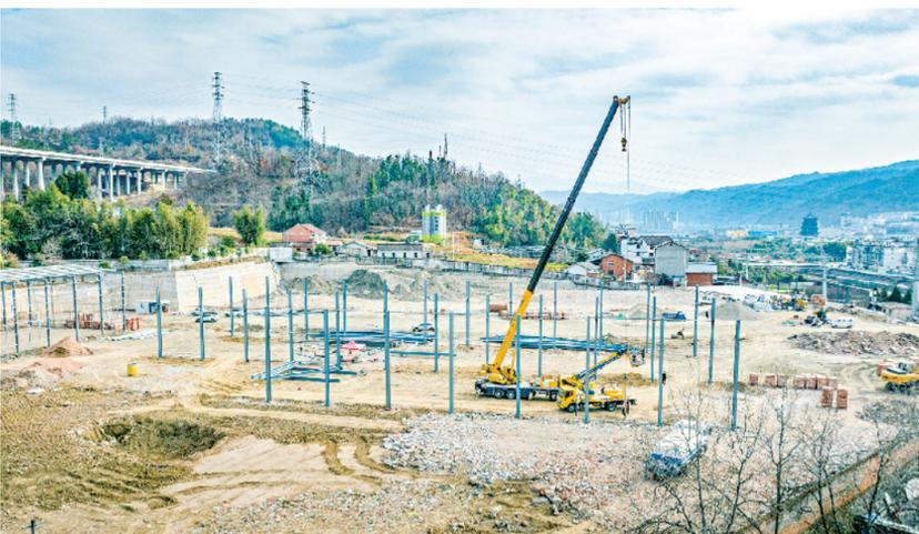
在石泉县报废机动车资源回收项目施工现场，工人们正利用重型起吊工具搭建标准化拆解车间厂房，预计1月底完成项目主体建设。董长松 摄
