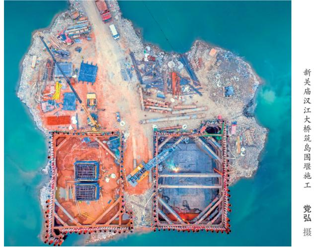
新关庙汉江大桥筑岛围堰施工 党弘 摄
