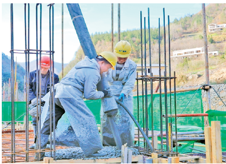
大湖溪舍子项目施工现场,施工工人正在进行浇筑作业 屈光波 摄
