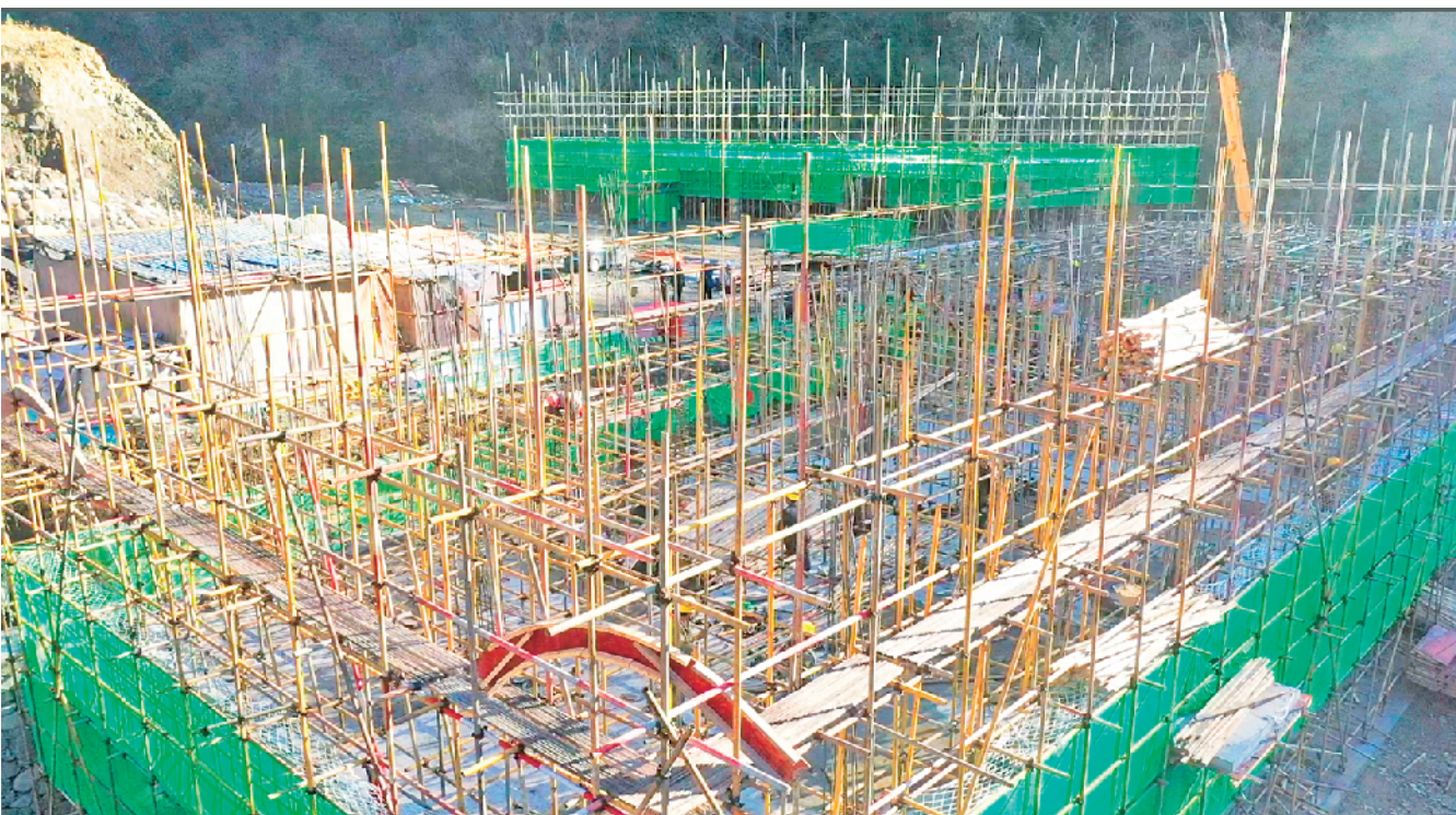
芳心小筑子项目施工现场工人正绑扎钢筋 屈光波 摄
