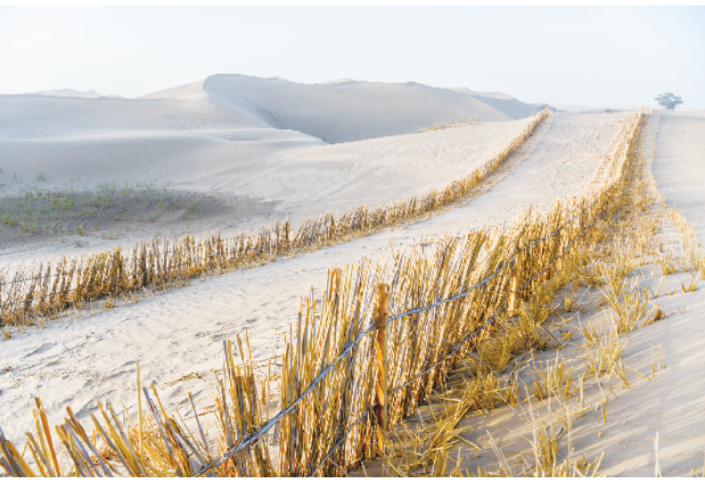
这是在新疆尉犁县且末县沙漠公路的施工现场拍摄的用于防风固沙的“芦苇沙障”(2018年7月10日报)。新华社记者 胡虎虎 摄
